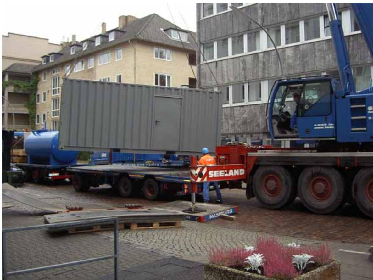
Abladendes Stromaggregates (in diesem Beispiel 1.100KVA)
