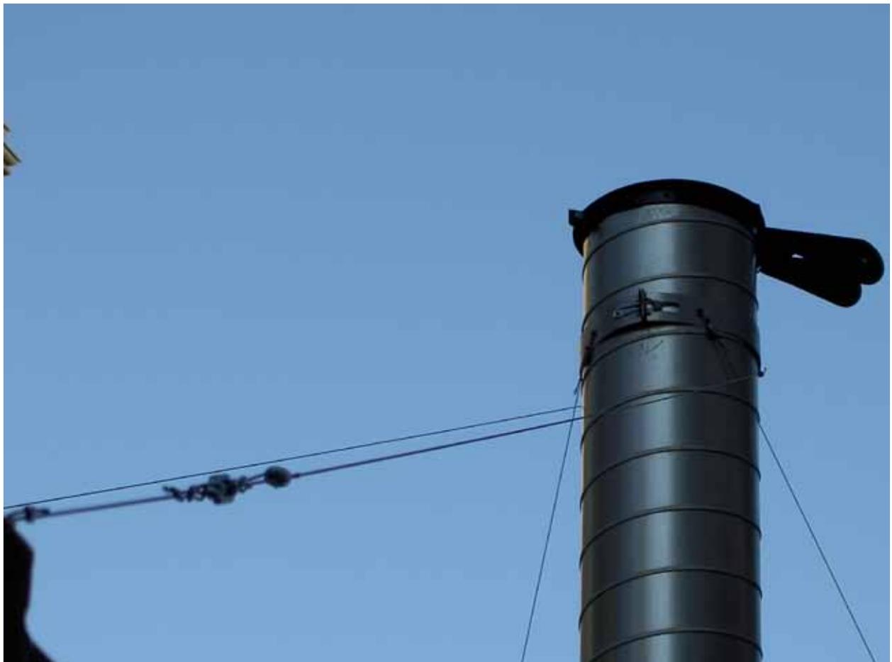
Aufsetzen einer Abgasverlängerung um Abgasbelastungen der Mitarbeiter im unmittelbar angrenzenden Bürogebäude zu vermeiden
