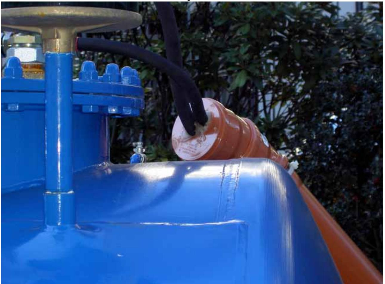
Anschluss und wasserdichte Verlegung der Kraftstoffschläuche vom externen 8.000 Liter Tank...
